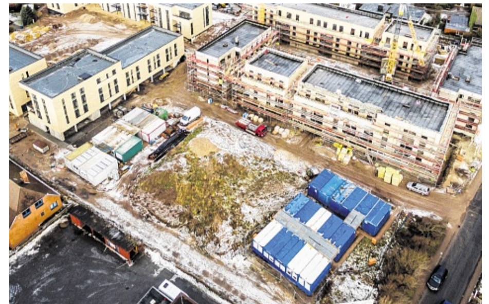
Auf der freien Fläche zur Dänischen Schule baut KLM zum Schluss zehn Reihenhäuser, die dann in Erbpacht vergeben werden. IMMOFOTO-SYLT.DE – LARS NEUGEBAUER (2)
