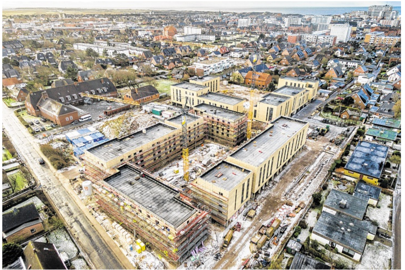
Der Bastianplatz aus der Luft: Im Vordergrund die Wohngebäude von KLM, dahinter die fast fertigen Genossenschaftsbauten.
