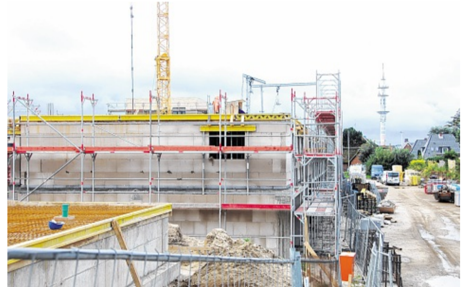
Mitten in Westerland baut auch KLM – 60 neue Dauerwohnungen entstehen dort.
